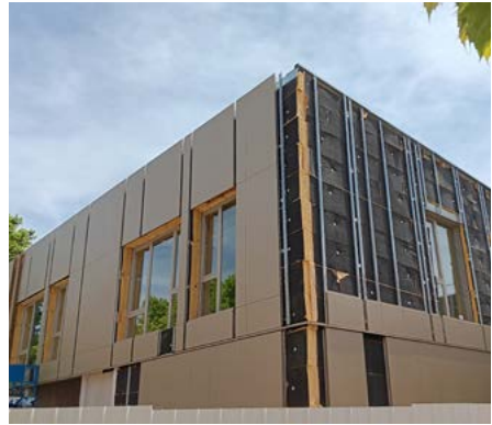
Pose des nouveaux parements sur les façades, côté rue de la République (juin 2025).
