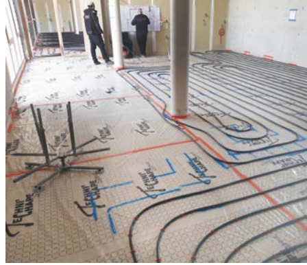
Le système pour le plancher chauffant a été mis en place (en mars 2025).
