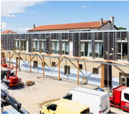
L'enveloppe extérieure du bâtiment prend vie avec la pose du bardage (mai 2025).
